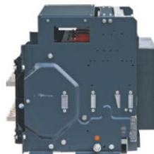
Disconnect – положение «выквачено»
